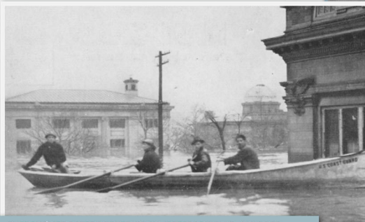
OVERSVØMTE GATER I SENTRUM AV JEFFERSONVILLE. JAN 1937
